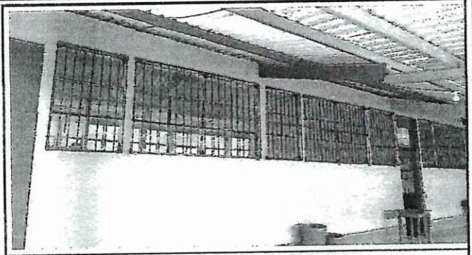
Foto 8: Así se quedo la sustitucion de balcon de ventana.
