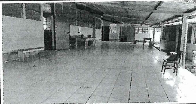
Foto 1: Así se quedo terminado el trabajo del corredor de la Escuela.
