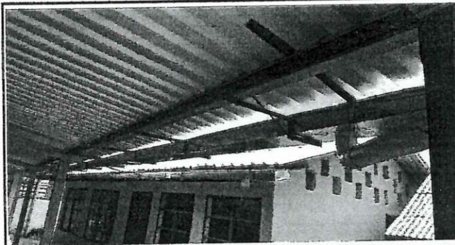
Foto 7: Así se quedo el trabajo de la sustitucion de canal con metal.
